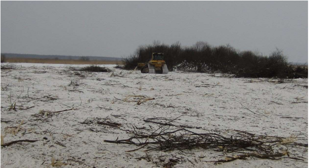
Joonis 6. Võsa ja mätaste eemaldamine Alam-Pedjal Emajõe luhal sahkamise teel.
